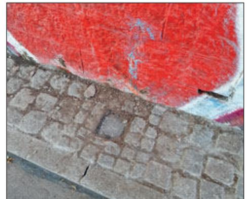
Im Rahmen des Ausbaues Tunnelweg in Stollberg (2. Bauabschnitt vom Tunnel bis Glückaufstraße) wurden im Tunnelbereich 4 Stück Bodenstrahler (LED, 5 W, blaues Licht) eingebaut. Die Leuchtenabdeckung erfolgte mit VSG-Glas, überrollbar mit 1,5 t Radlast.
